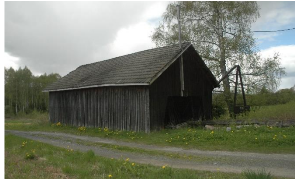
Steinhuggerverkstedet Nerengen før demontering.
