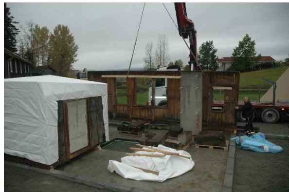
Kontordel og tidligere nordvegg gjenoppført på ny, støpt sokkel på Hadeland Folkemuseum.
